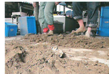
La terre est broyée et trempée dans l' eau; elle est ensuite égouttée et piétinée.
